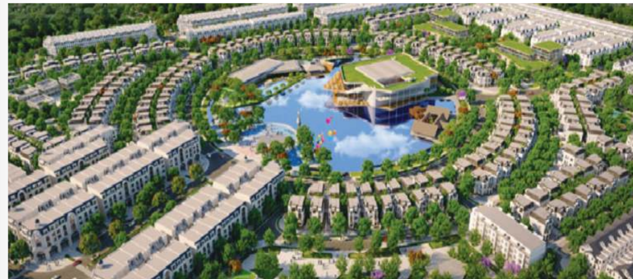
Phân khúc nhà ở thấp tầng tại Hà Nội ngày càng "tăng nhiệt"
